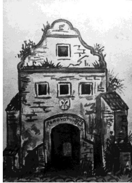
Ryc. 5. Głogówek, Brama Wodna (Prudnicka), widok od wschodu sprzed rozbiórki 20 .
