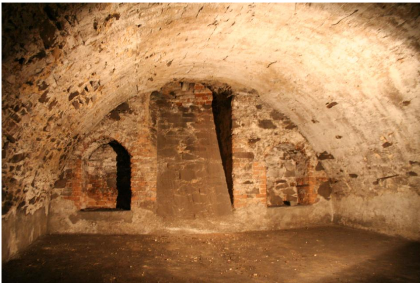
Ryc. 6 Grobniki, Komenda, piwnice, widok jednej z komór, widok obecny.
